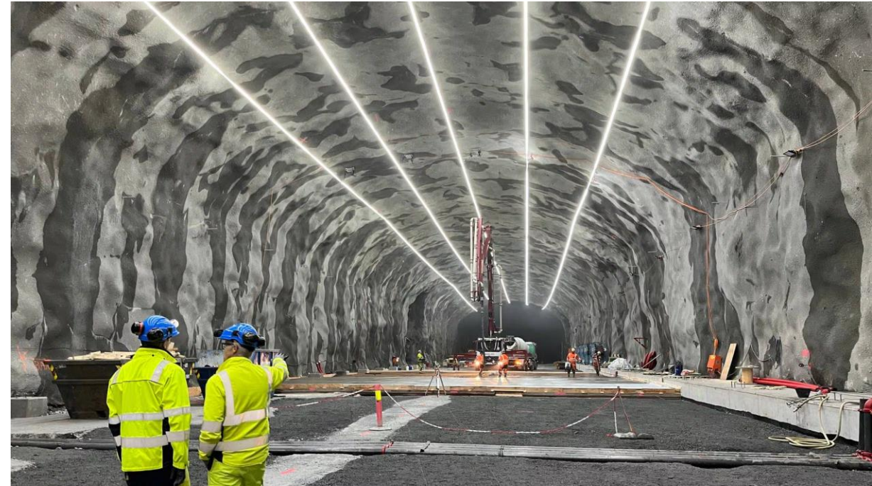
FOTO: HELLE MJØS / VANN- OG AVLØPSETATEN
